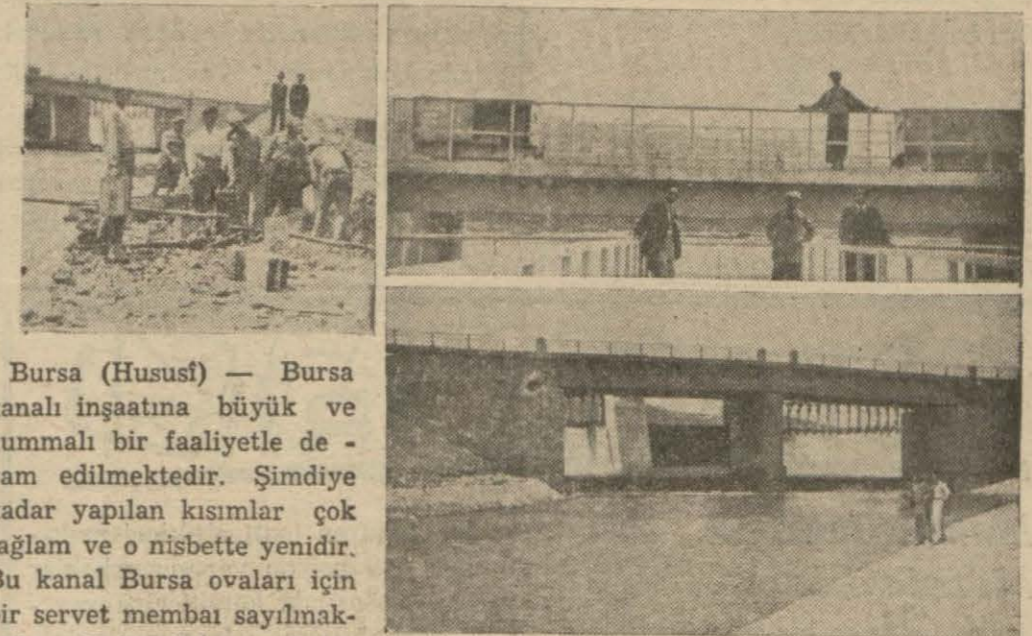
Bursa kanalı inşaatından birer görünüştür.
